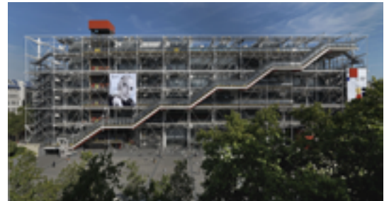
1. ポンピドゥー・センター外観 © Centre Pompidou / Georges Meguerditchian
