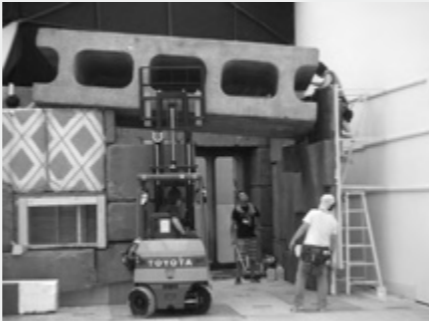
電動のフォークリフトも使用した建て込み
