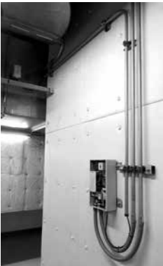
写真3 ダクト挿入型写真 CO 2 濃度計測定器
